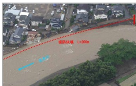
侵食により家屋が流失した状況
